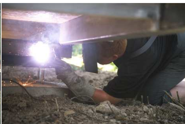
Obr.7: ...a na přesně horizontálně vyváženém otočném věnci svařen.
